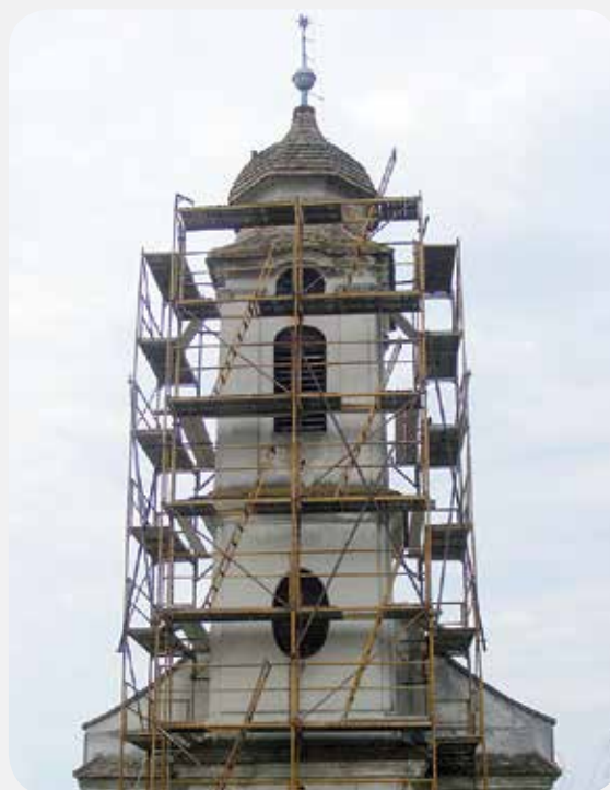
A sárkeresztesi református templom felújítás közben
